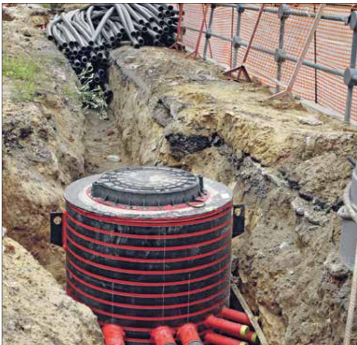
Кабели и провода убирают в коллекторы
